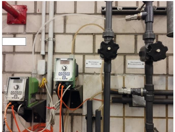
Abbildung 1: Dosiertechnik für die Zugabe von Biozid und Korrosionsinhibitor zum Nutzwasser einer Verdunstungskühlanlage.
